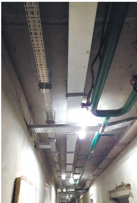
Использование ОКЛ ELTROS OKLine на объекте строительства ЖК «Квартал «Match Point».
