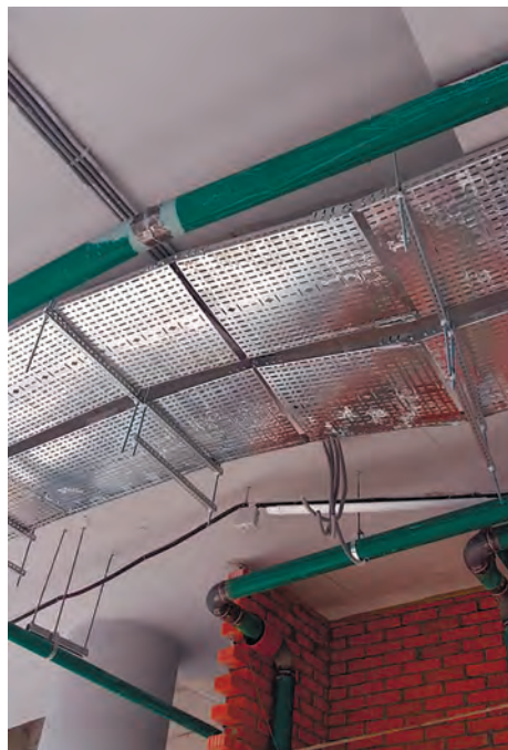
Использование ОКЛ ELTROS OKLine на объекте строительства ЖК «Квартал «Match Point».
