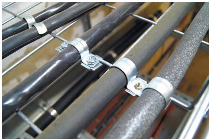
Вариант крепления огнестойкого кабеля в металлическом проволочном лотке с помощью скоб однолапковых.
