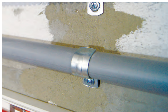
Вариант крепления гладких жестких труб при помощи скоб однолапковых.
