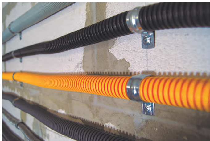
Вариант крепления гофрированных труб с помощью скобы однолапковой.
