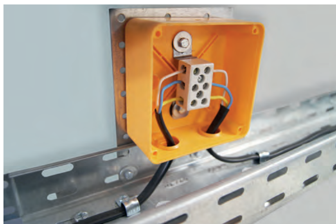
Вариант монтажа огнестойкой распаячной коробки.
