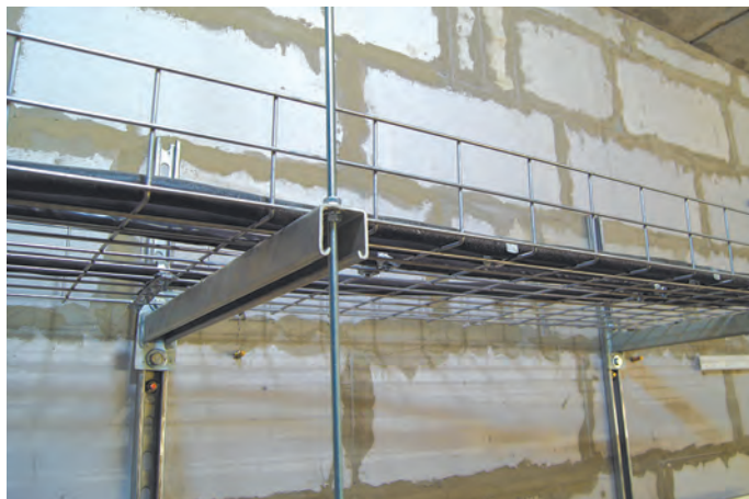
Вариант крепления металлического проволочного лотка при помощи кронштейнов.
