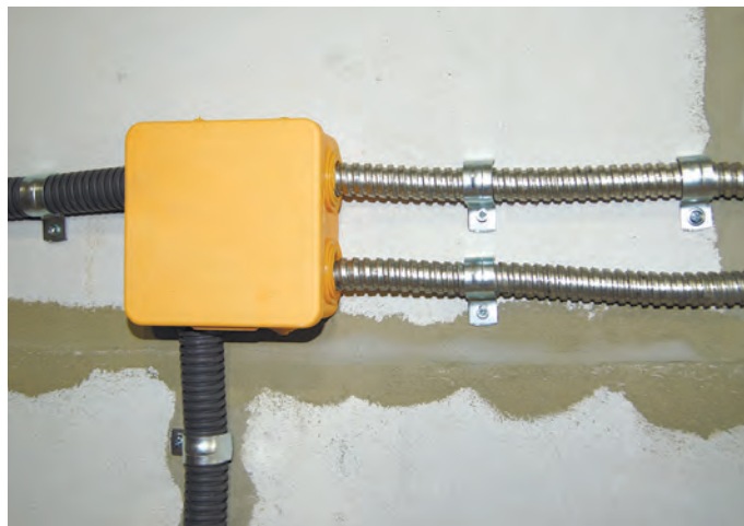
Вариант прокладки огнестойкого кабеля в металлорукаве, разводка кабеля в распаячной огнестойкой коробке производства ЗАО «Рувинил».
