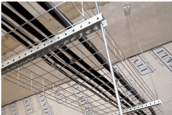
Вертикальный подвес металлического проволочного лотка на шпильках к бетонному перекрытию.
