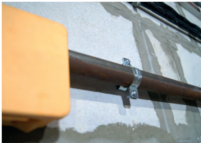
Прокладка кабеля в трубе стальной электросварной при помощи дистанционных скоб, ввод кабеля в распаячную огнестойкую коробку производства ЗАО «Рувинил».
