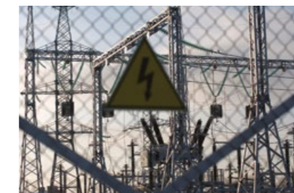
Реконструкция трансформаторной подстанции г. Севастополь
