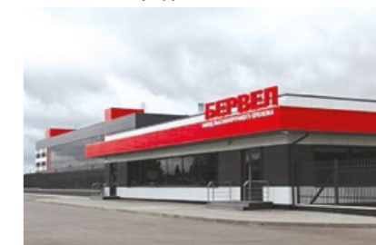
Завод высокопрочного крепежа «Бервел» г. Санкт-Петербург
